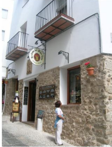
Fachada en correcto estado de conservación y práctica inexistencia de ocupación de vía pública
