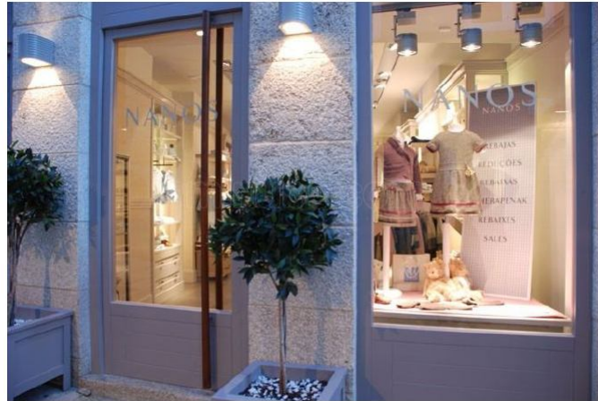
Fachadas en correcto estado de conservación y práctica inexistencia de ocupación de vía pública
