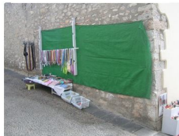
Ocupación de la parte trasera del Museu del Mar. Anclaje de soportes en muro
